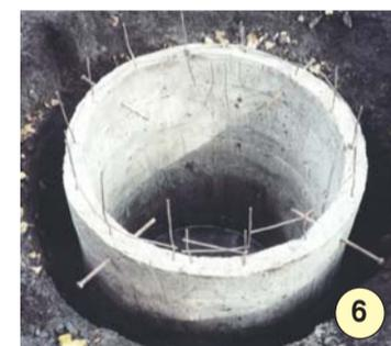
Промежуткам между железобетонными кольцами и неразработанным грунтом (6) не страшны даже перекосы колодца, что вполне возможно. Эти перекосы очень просто устраняются подкопом с противоположной от перекосившейся стороны. Метод опускного колодца с «ножом» может применяться при строительстве погребов даже в обводненных условиях.
